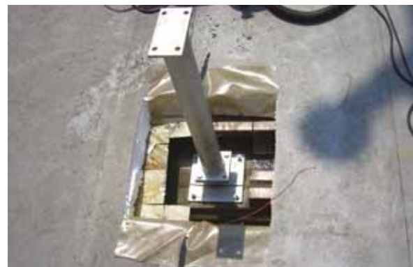
Bild 6: Einbindung Montagesystem (Quelle Schletter)
