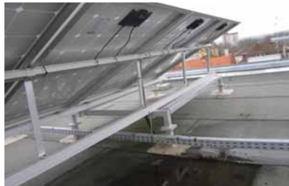
Bild 15: fachgerechte Leitungsverlegung (Quelle VGH)
