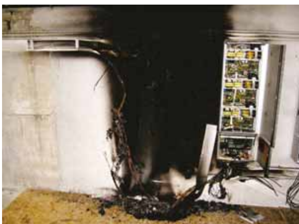
Bild 21: Brandschaden durch lose Klemmstelle an einem PV-Verteiler, aufgrund eines falsch eingelegten Gewindeplättchens, siehe rechts (Quelle Markus Scholand)
