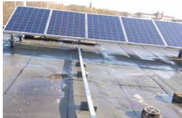
Bild 14: nicht fachgerechte Leitungsverlegung (Quelle VGH)
