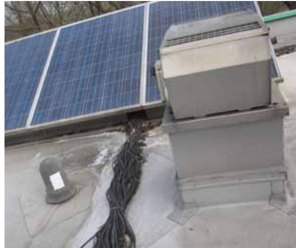
Bild 14: nicht fachgerechte Leitungsverlegung (Quelle VGH)
